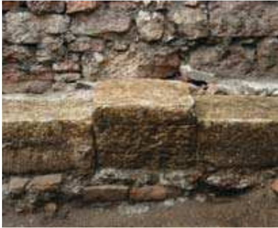
Fig. 5. Trento, Facoltà di Sociologia. Particolare di un basamento di pilastri del grande edificio porticato.
