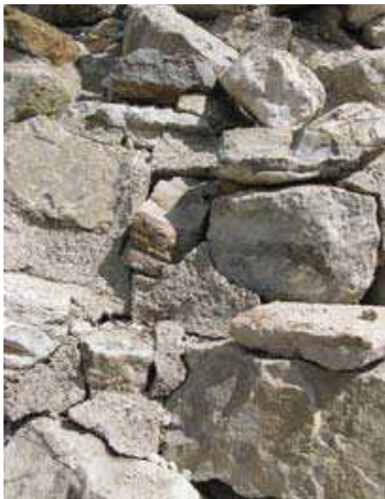
Fig. 2. Monte S. Martino (Riva del Garda). Effetto del gelo sulle malte dopo un inverno.
