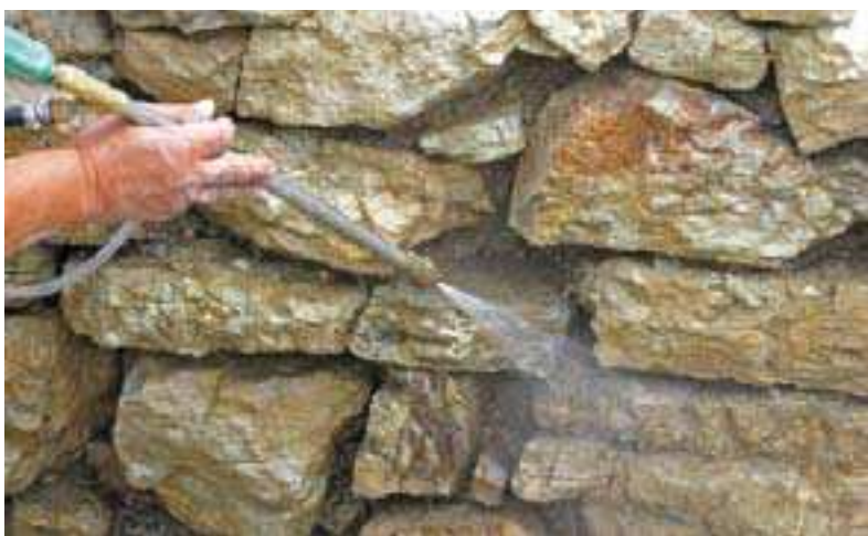
Fig. 3. Monte S. Martino (Riva del Garda). Iniezioni di malta micronizzata in profondità.
